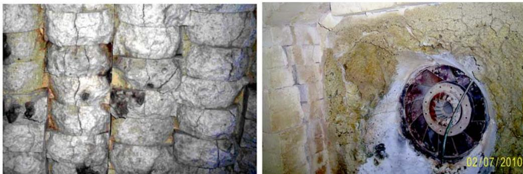
**Рис. 1.** Эрозия футеровки сушильной печи на ОАО «Доломит»
