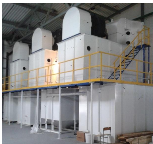
Рисунок 4 – Газоочистной комплекс в стадии монтажа. Введен в эксплуатацию в 2015 г.
