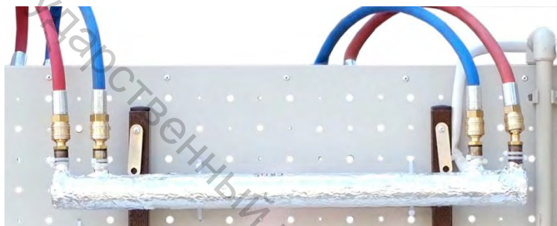
Рисунок 6.3 – Измерительный модуль, установленный на лабораторный стенд
